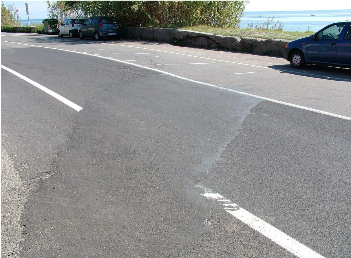
Fig. 4.13 Fratturazione del manto stradale lungo il piano di faglia della faglia della Pernicana presso Fondachello.
