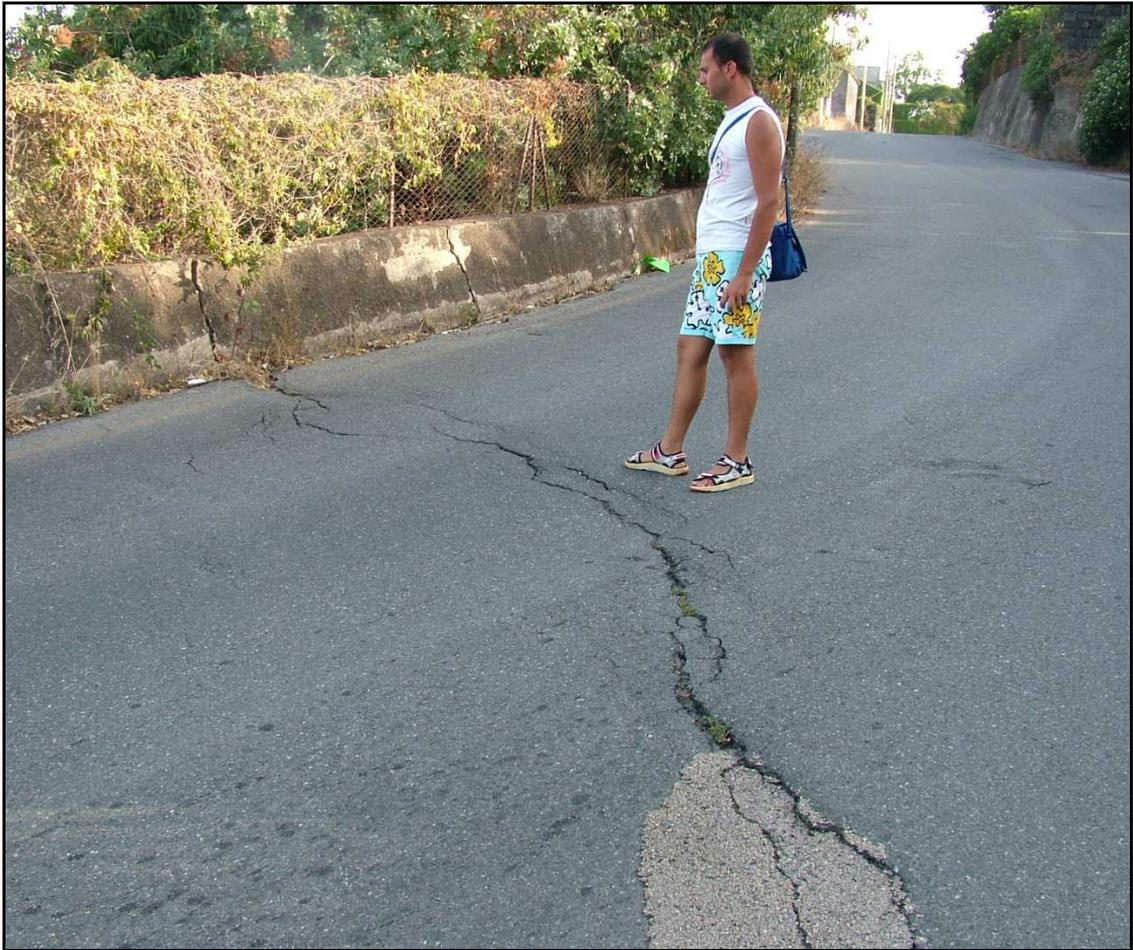
Fig. 4.12 Fratturazione del manto stradale lungo il piano di faglia della faglia di S. Leonardello
