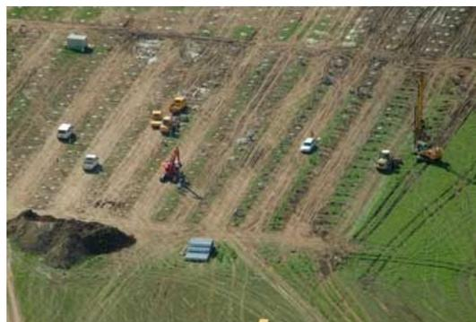
Figura 10. Fasi di costruzione Bavaria Solarpark, tracciamento strade, palificazione, realizzazione dell'impianto (Foto C. Eco)
