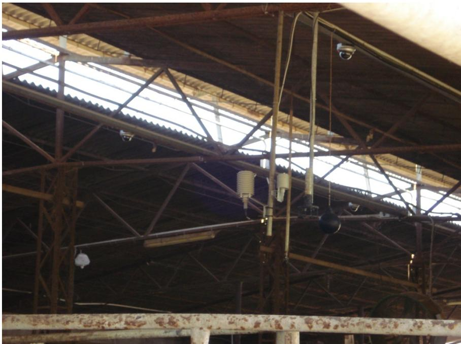
**Figura 10 – Sensori per la misurazione dei dati termo-igrometrici all'interno dell'edificio zootecnico**
