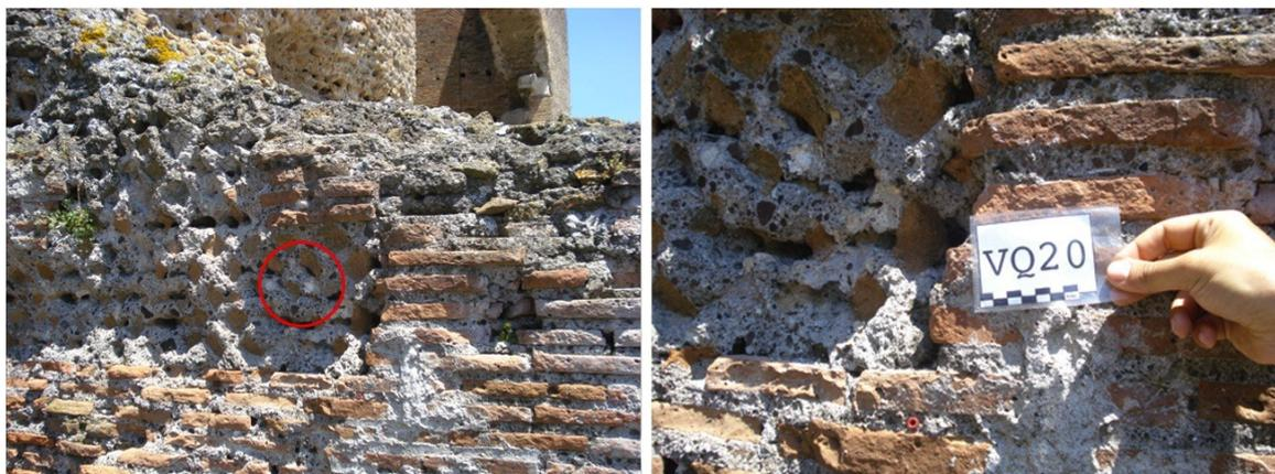
Figura 14. A sinistra foto generale del paramento murario dal quale è stato prelevato il campione VQ20 (a destra).
