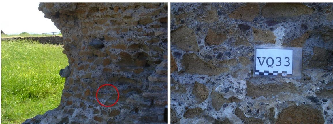
Figura 19. A sinistra foto generale del paramento murario dal quale è stato prelevato il campione VQ33 (foto a destra).
