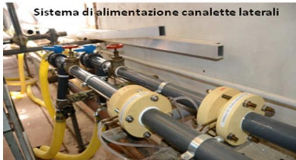
**Figura 5.5** Sistema di alimentazione idrica che consente la regolazione della portata in ingresso alle due canalette laterali
