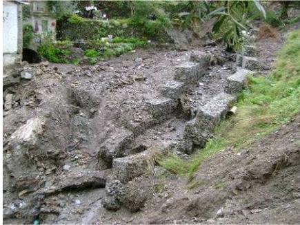
**Figura 4.12** Torrente Sopra Urno: opere di protezione realizzate dal Genio Civile di Messina a seguito dell'evento del 2007.
