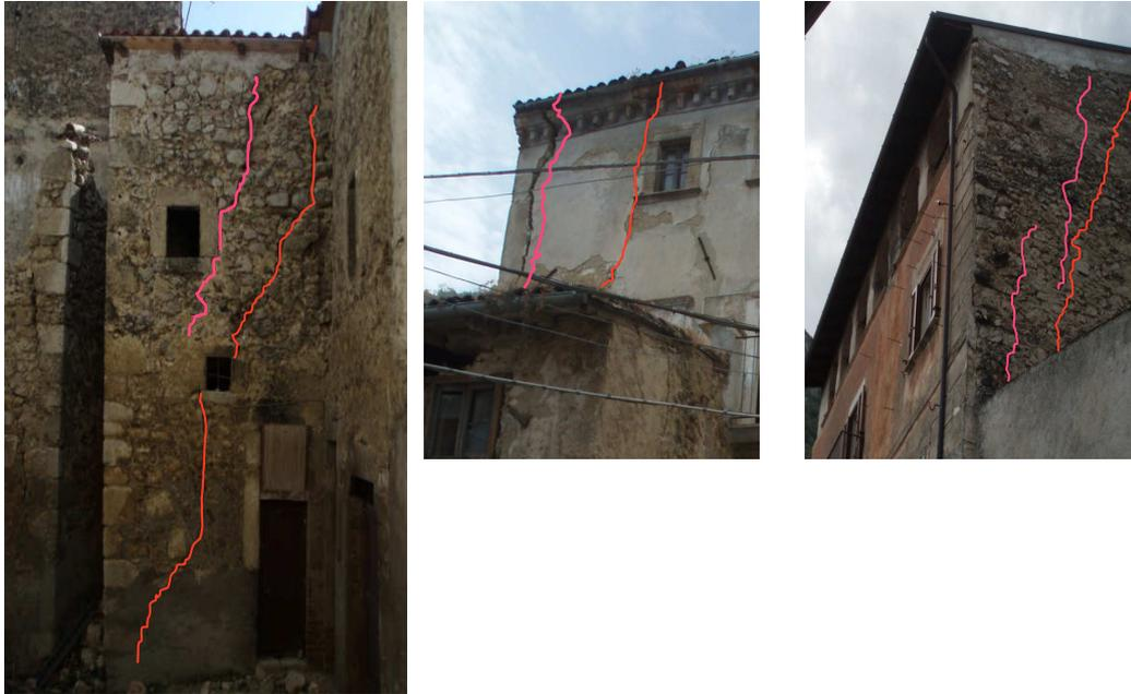
b) Seconda fase: l'evoluzione del meccanismo procede con l'apertura di una seconda lesione, meno inclinata, che delimita una porzione più piccola di muratura.
