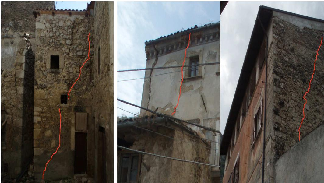
a) Prima fase: fessurazione e distacco di un'ampia porzione di muratura con  $\beta > 30^\circ$
