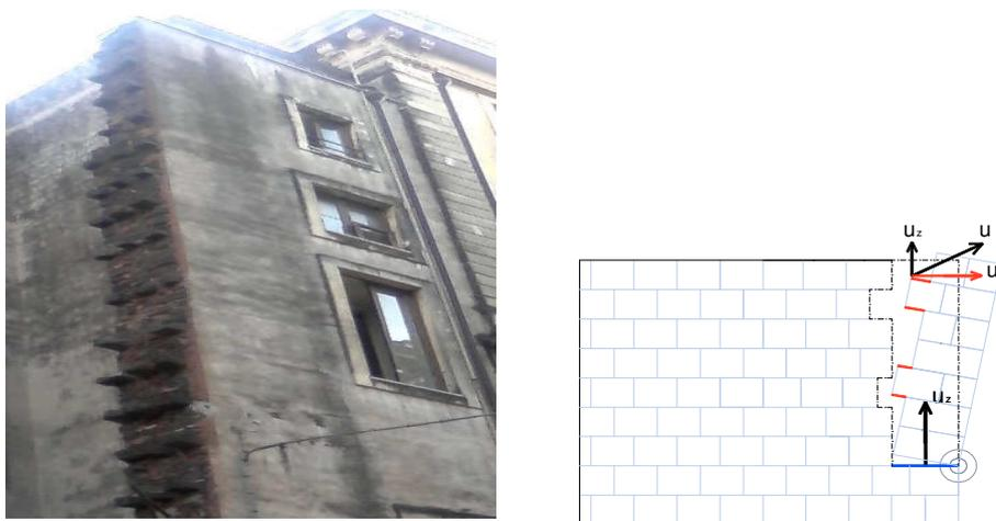
Figura 5.21 - a) Esempio di parete semi ammorsata; b) Valutazione resistenze attritive
