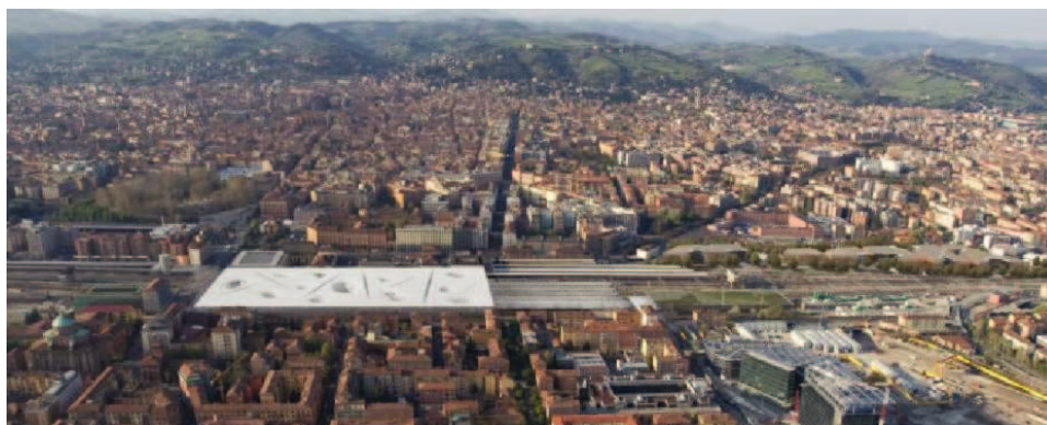
Vista della proposta di A.Isozaki (2007) per la stazione di Bologna: una struttura piastra sui binari si affianca al vecchio edificio dell'ingegner Ratti, collegando i vari livelli del nodo.
