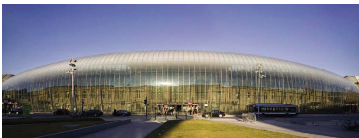
La facciata della stazione di Strasburgo, coperta dalla nuova galleria esterna (2003-2007)
