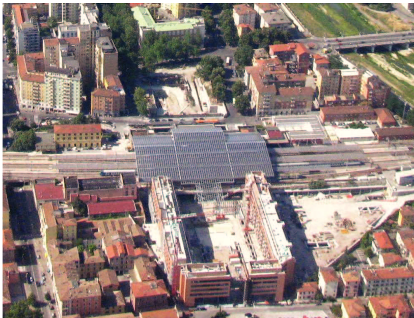
Vista dell'area di cantiere della stazione di Parma da nord (giugno 2012)
