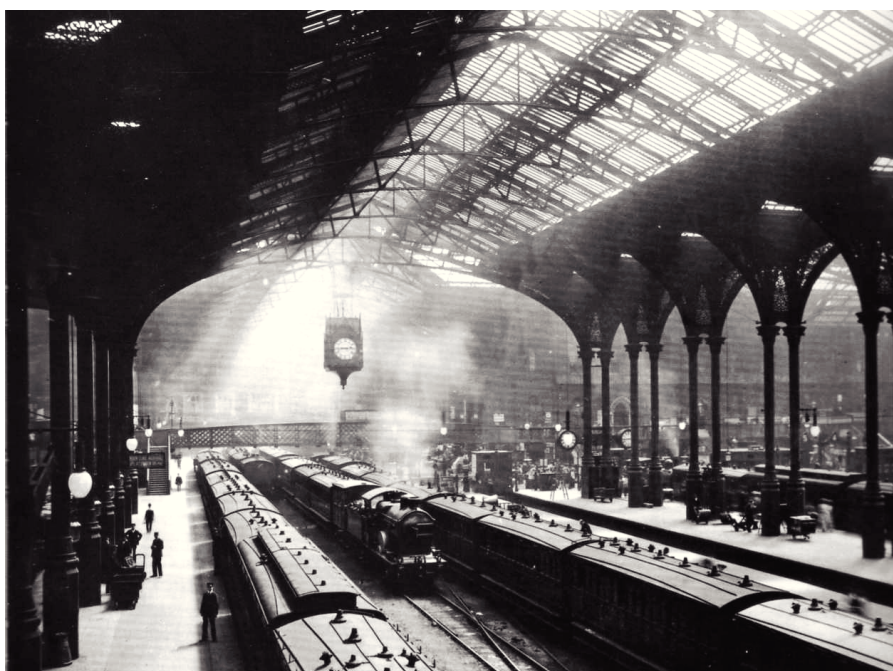
La 'navata' principale della Liverpool Street Station a Londra (1875). Si intravede l'Hotel, che fa da fondale a questa e sulla destra l'edificio ad L che chiude la 'navata' più corta.
