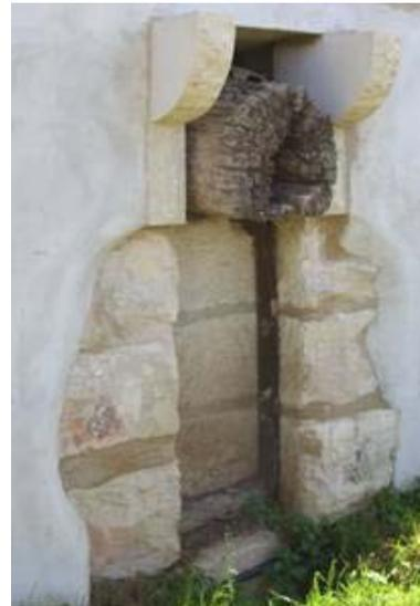
Figura 53 - Vincolo al muro della testa della trave pressante.
