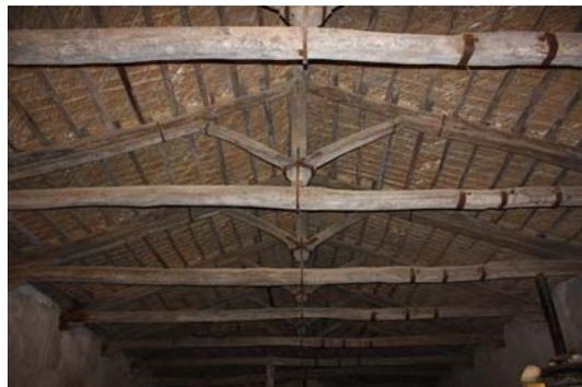
Figura 114 Struttura della copertura del palmento.
