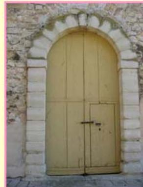
Il vano del portone (2.54 × 4.00 m) sul prospetto rivolto a est del palmento è realizzato con un arco a sesto ribassato ottenuto dall'accostamento di conci lapidei tagliati secondo le regole della stereotomia. Le spallette sono realizzate con conci disposti con la dimensione dominante parallela al piano del paramento murario.
