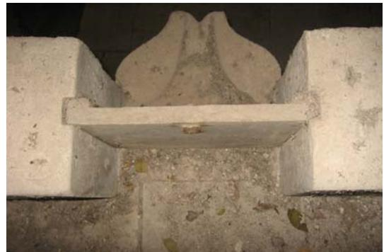
Figura 66 - Canaletta di sgrondo posta sulla pista di pigiatura (Azienda Fegotto - Chiaromonte Gulfi)
