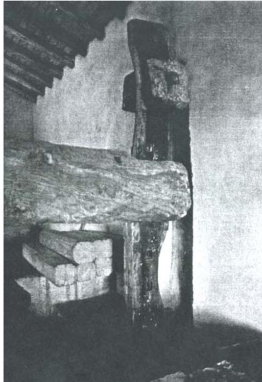
Figura 54 - Vincolo a muro in alcuni torchi a bilancia. Fonte: Acquaviva, 1995.
