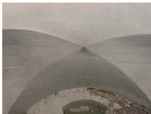
Figura 110 - Volta a crociera presente a copertura dei locali del frantoio.
