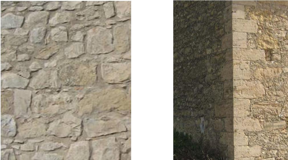
**Figura 73 - Muratura di pietrame informe e malta di calce e particolare di un cantonale.**
