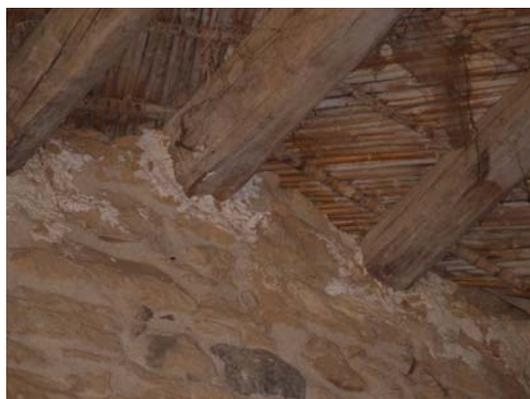
Figura 74 - Particolare del colmo di una copertura con struttura portante in legno.
