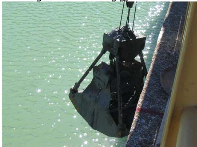
**Figura 3.37 Dragaggio in prossimità degli scarichi di fondo**
