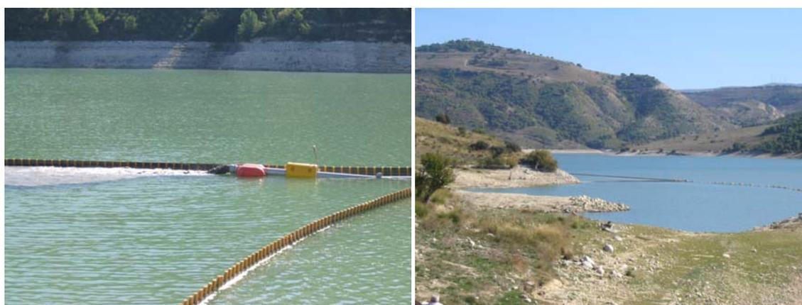
**Figura 3.41 I fanghi aspirati in prossimità dello sbarramento vengono depositati nell'area di stoccaggio (sinistra) delimitata da barriere mobili (destra).**
