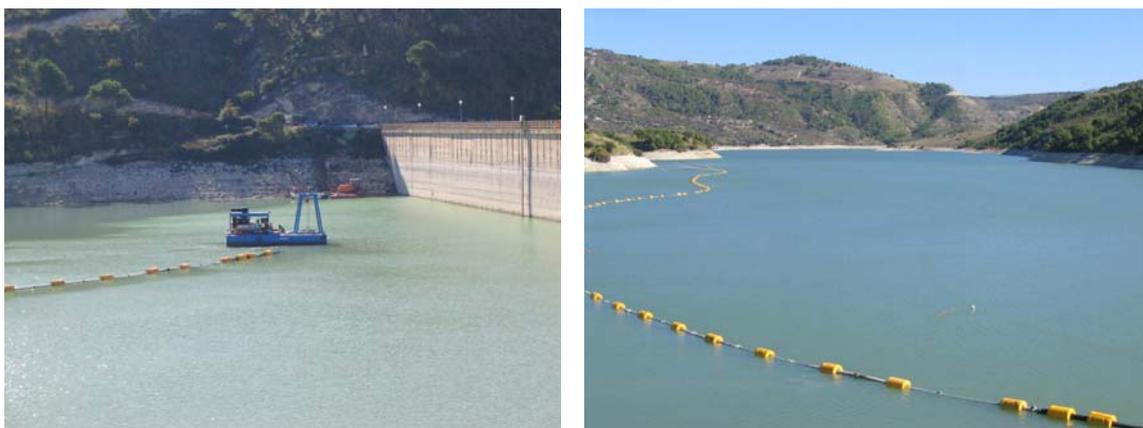
**Figura 3.40 Gruppo dragante in azione (sinistra); i fanghi aspirati vengono pompate, attraverso una condotta galleggiante, verso l'area all'interno del serbatoio destinata allo stoccaggio (destra)**
