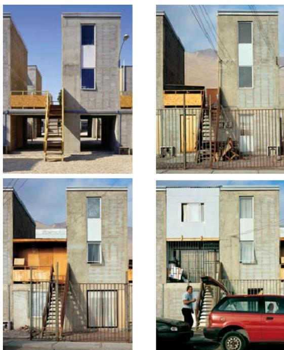
Fig.3 Fasi di ampliamento unità edilizie.
