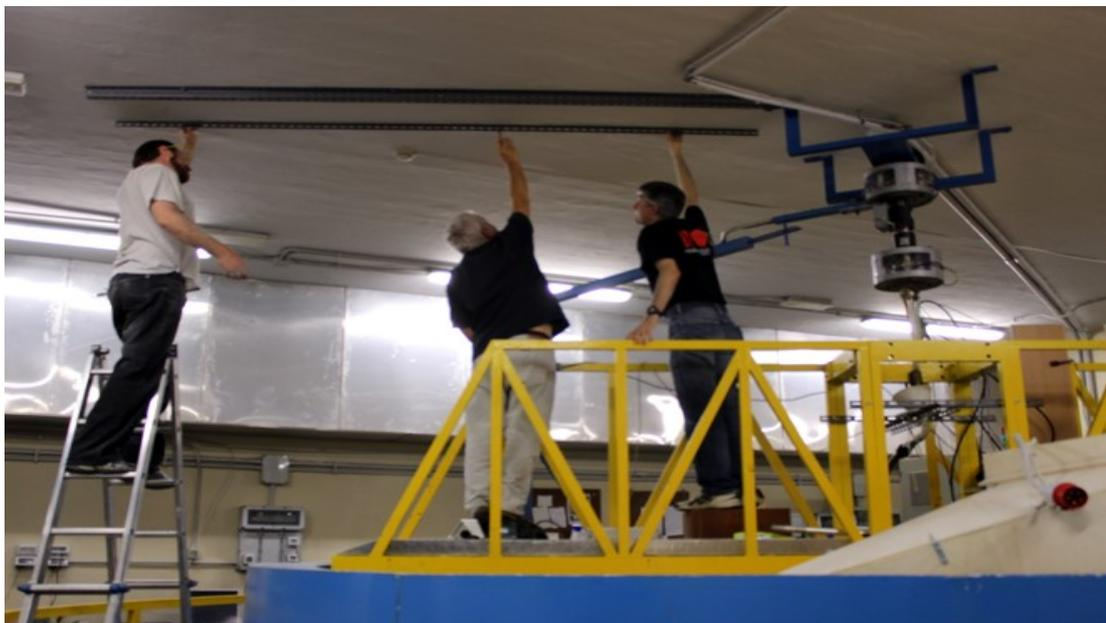
Figura 4.9: Fotografia delle fasi di montaggio delle guide sul soffitto sopra la vasca rotante.
