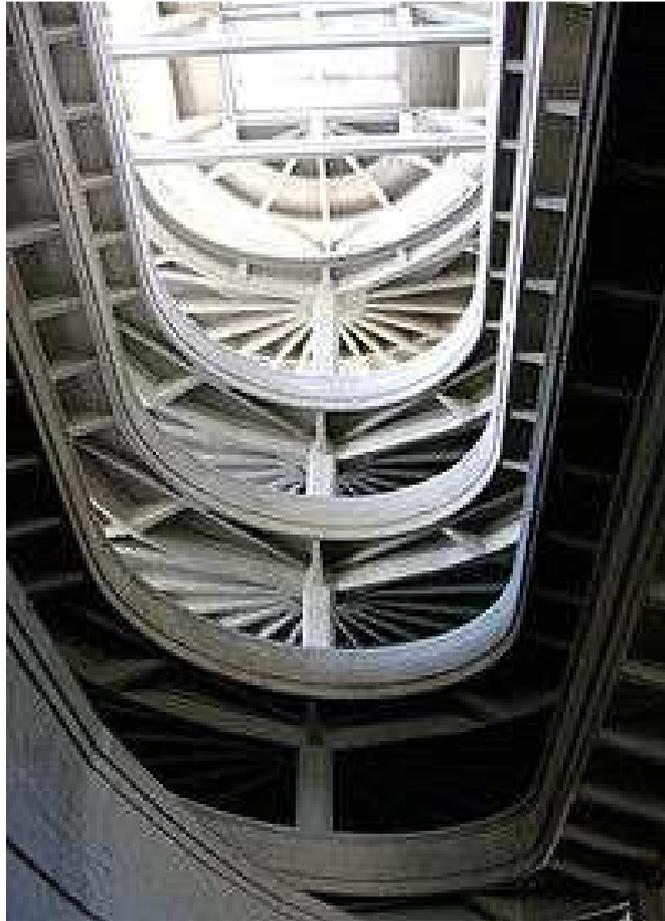
Fig. 39: La rampa elicoidale che collega i vari piani della fabbrica
