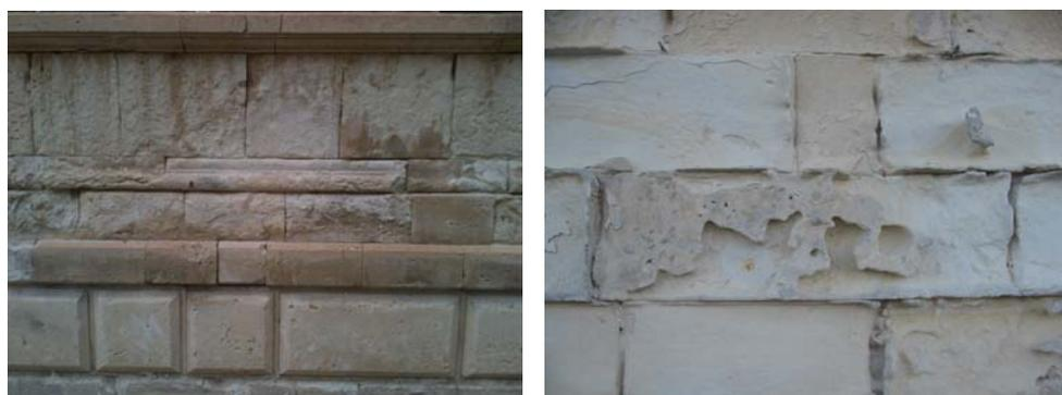
Figura 4 - Bugnato in via dei Montalto e rivestimento di cm 8 in un edificio sul Passeggio Aretusa
