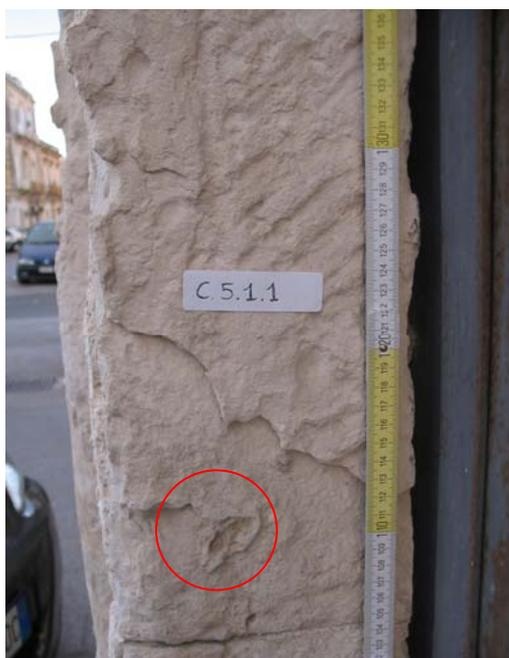
Figura 4 – Edificio in via R. Lanza: esempio di rottura lungo un piano di sedimentazione
