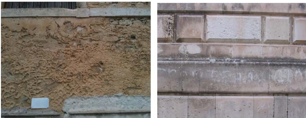
Figura 5 – Degradazione differenziale (Lungomare Ortigia) ed efflorescenza sulla pietra (via dei Santi Coronati)
