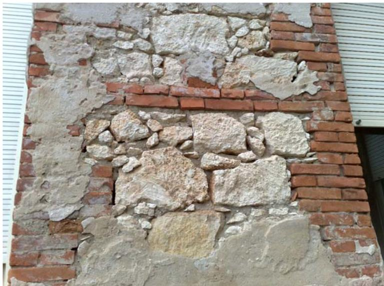
Figura 6 – Esempio di muratura listata (ex ONP, traversa La Pizzuta)
