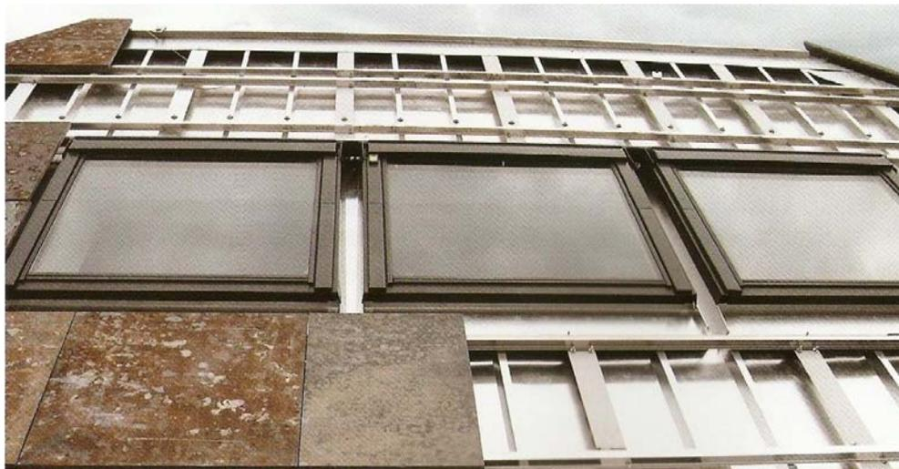
Figura 1 - Il Piol a Farra D'Alpago (BL). Dettaglio della copertura ventilata con rivestimento in ardesia e sistema meccanico di ancoraggio<sup>2</sup>
