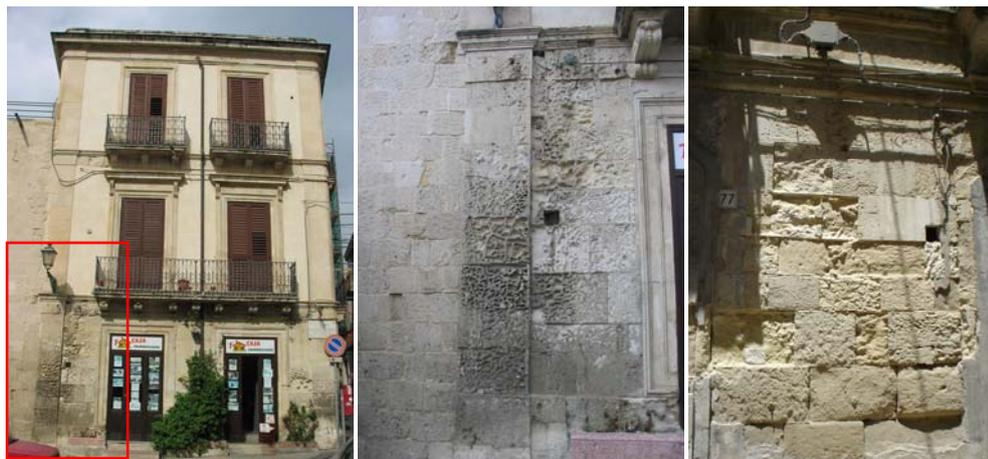
Figura 3 - Alveolizzazione ed erosione su due edifici in via R. Settimo e in via della Maestranza
