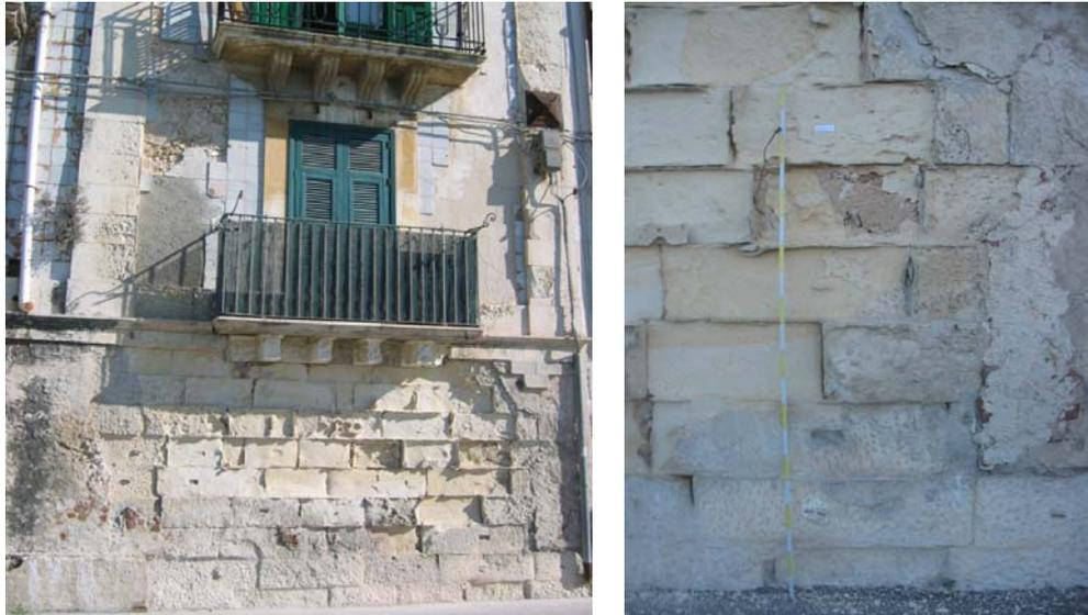
Figura 4 - Passeggio Aretusa. Conci erosi in funzione dell'altezza da terra
