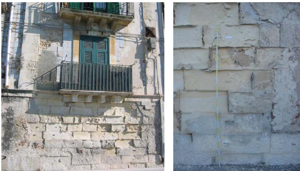
Figura 7 - Passeggio Aretusa. Conci erosi in funzione dell'altezza da terra
